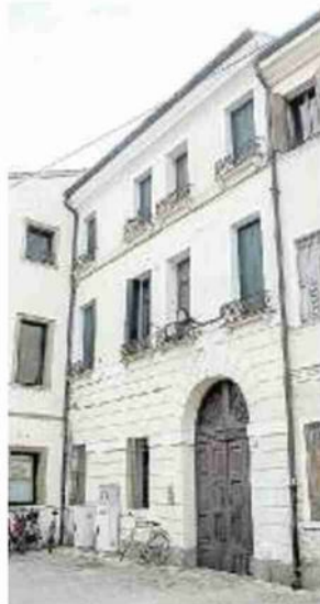
EX POLIZIA LOCALE Lo stabile in piazza Garibaldi
